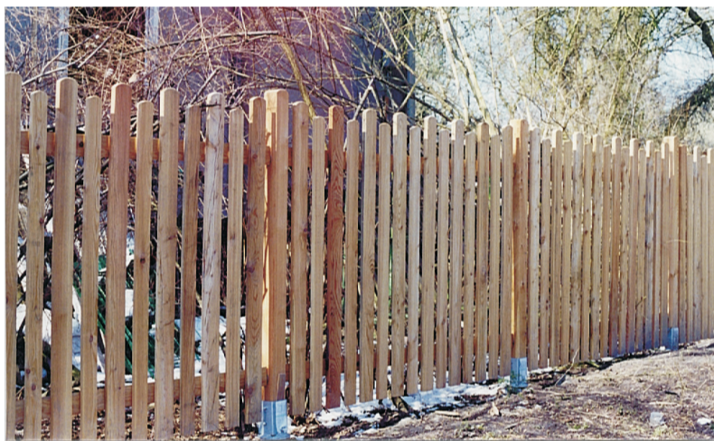
Lärchenzaun, Latten 7cm und 9cm abwechselnd in "Sägezahnform"
